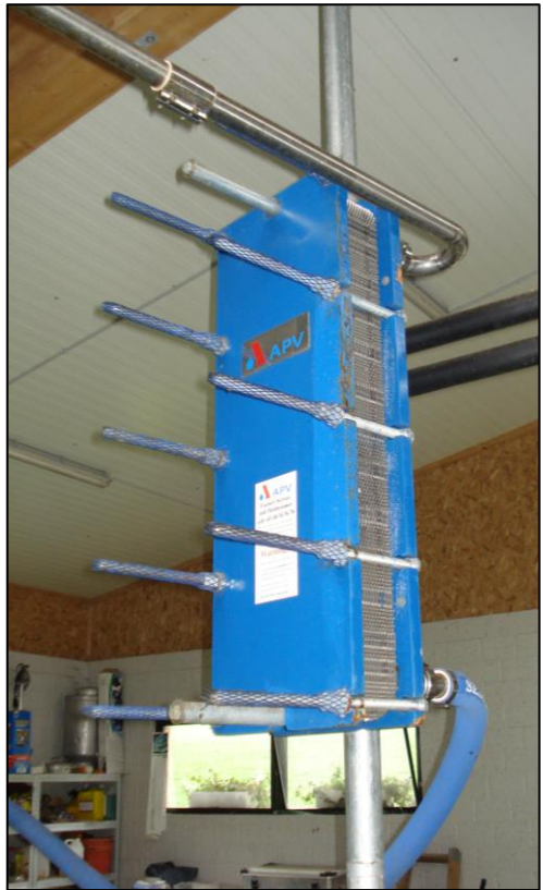
Plattenwärmetauscher für die Vorkühlung der Milch.
