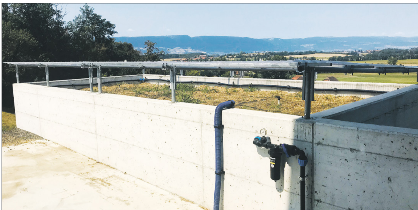
Zur Reinigung von Wasser mit Pestizidrückständen kann das Reinigungssystem Biobac eingesetzt werden. Es wird mit Beiträgen zu 50 Prozent unterstützt.
